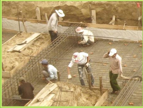
Các công nhân đang tạo những khung gỗ và lấp đầy chúng bằng sỏi và xi măng.
