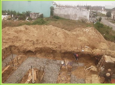
Các công nhân đang tạo những khung gỗ và lấp đầy chúng bằng sỏi và xi măng.
