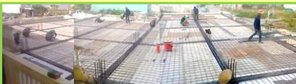
Hàng khối tấn sắt đã được sử dụng cho trần nhà. Phải mất một thời gian trước khi nó sẵn sàng để được lấp đầy bằng bê tông.
