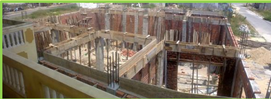
Sau một tháng các khung trần bằng gỗ được chế tạo
