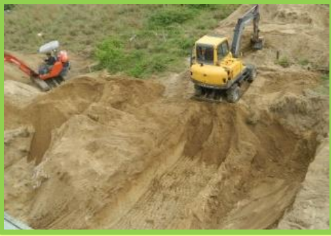
Hai máy xúc cỡ nhỏ bắt đầu đào xuống sâu khoảng 1.70m để xây dựng nền móng.
