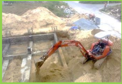
Nền móng đã được lấp đầy cát, để sẵn sàng cho việc xây lên 24 cột trụ
